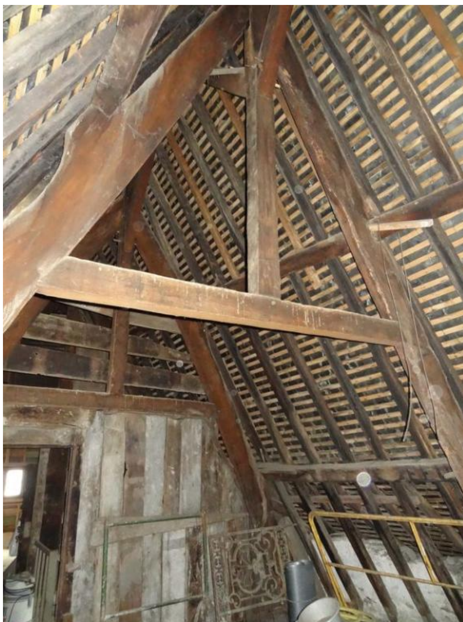
Ferme de charpente
