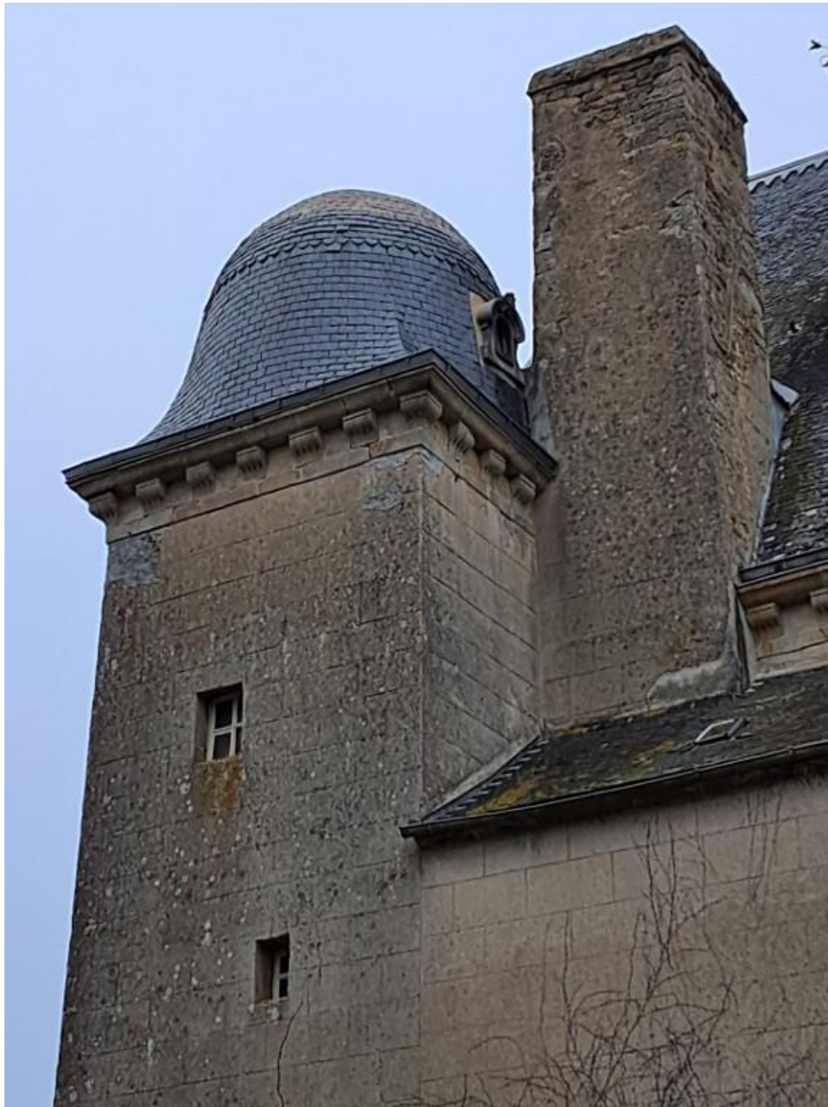
Pavillon Renaissance, tour carrée, toiture impériale et corniche à modillons
