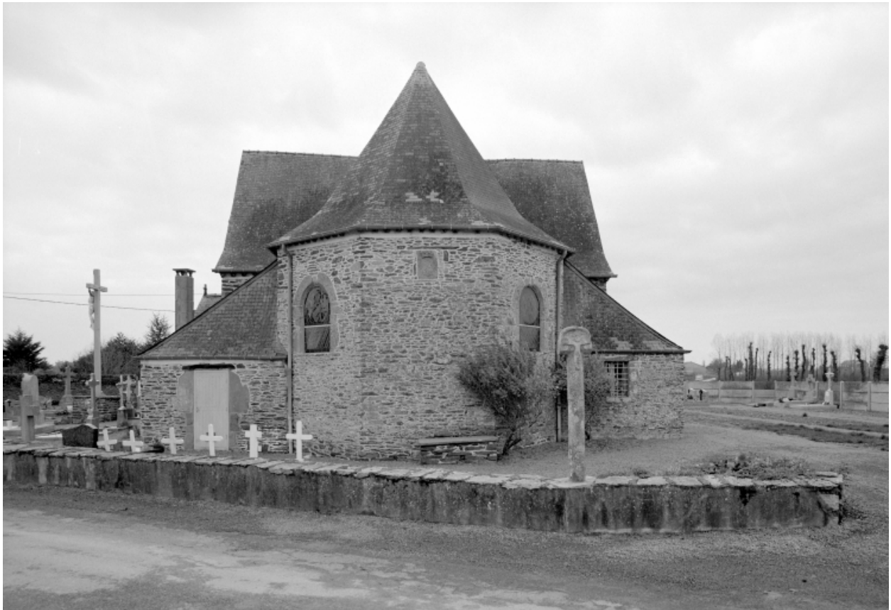
Elévation Est : vue générale
