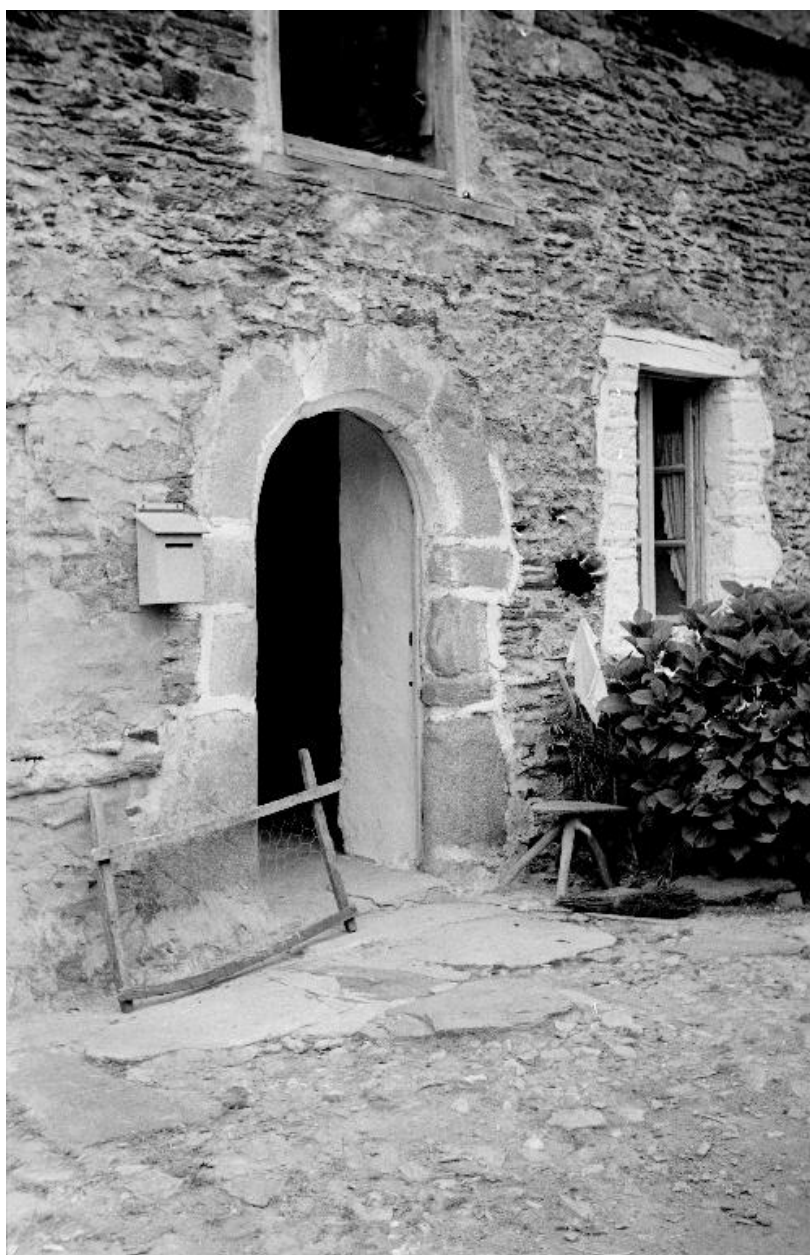
Ferme 29 : la porte (état en 1969)
