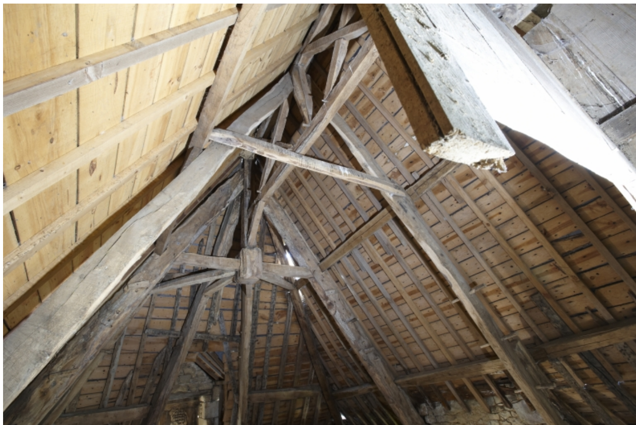
Charpente du pavillon
