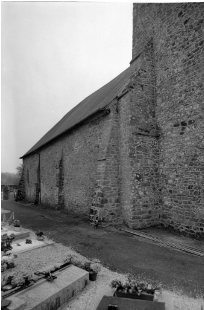
Façade ouest : demi-pignon nord de la nef.
