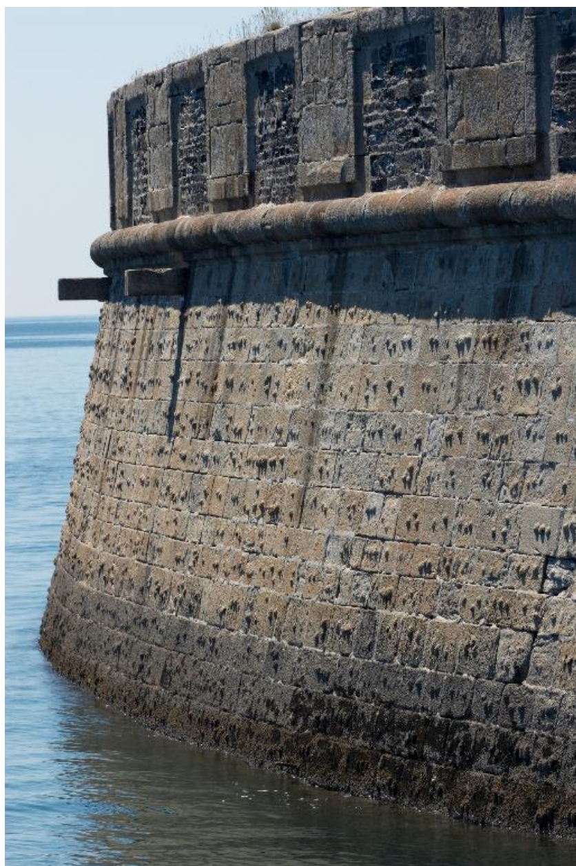
Plouzané : vue du fort du Mengant, batterie basse
