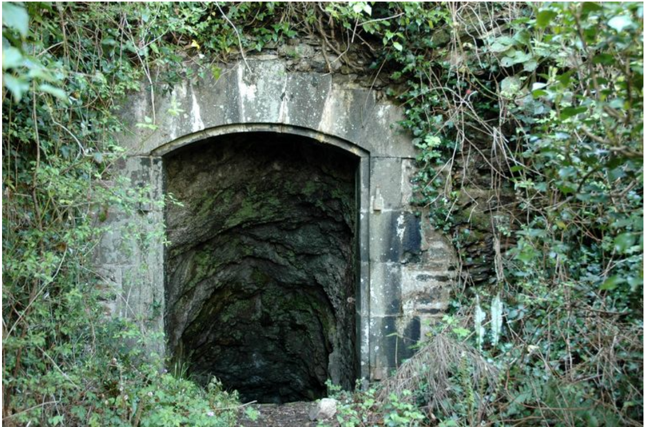
Vue de l'entrée de l'escalier - galerie d'accès (état en 2005)
