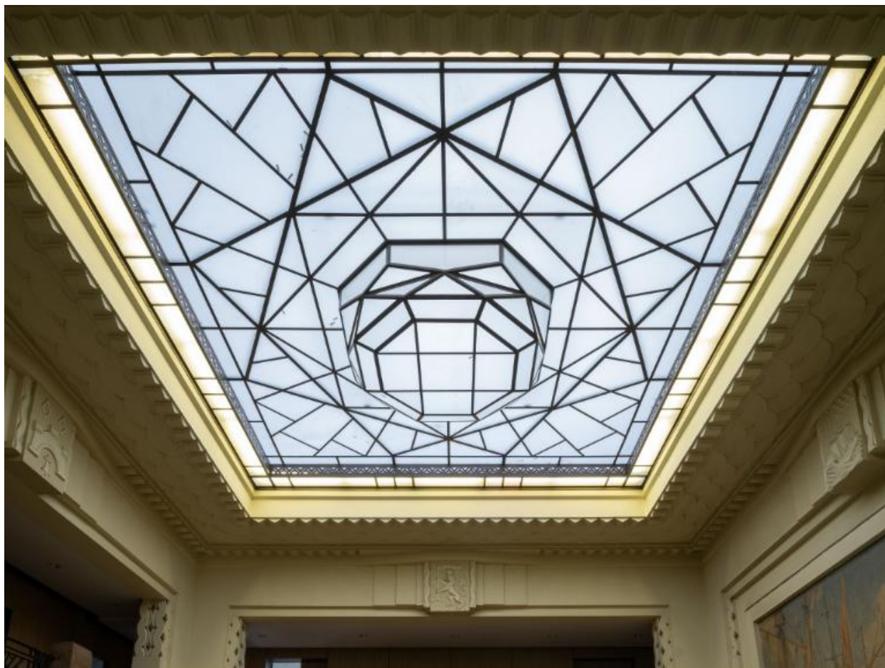
Verrière en couverture du hall principal.
