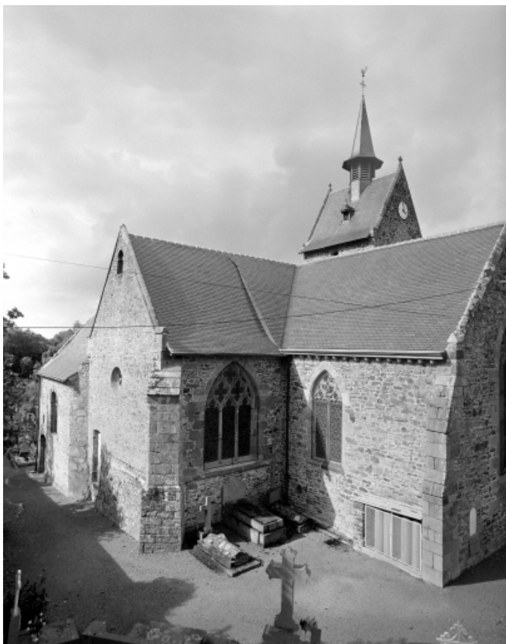
Elévation Sud-Est : vue générale
