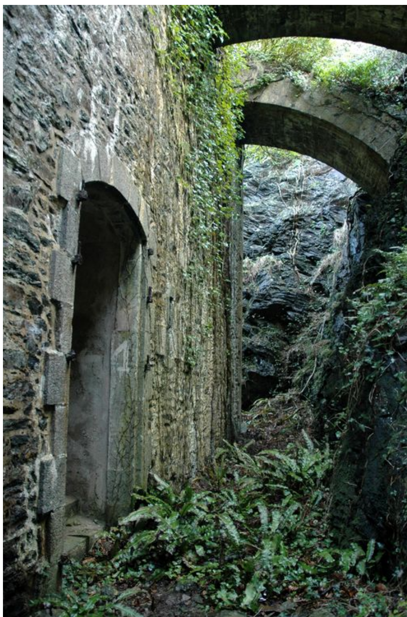
Vue de la caserne défensive Robert : entrée du magasin à poudre et arcs-boutants ouest
