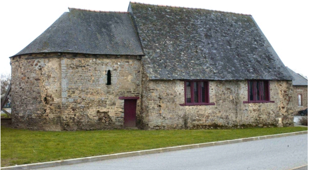
Vue générale nord
