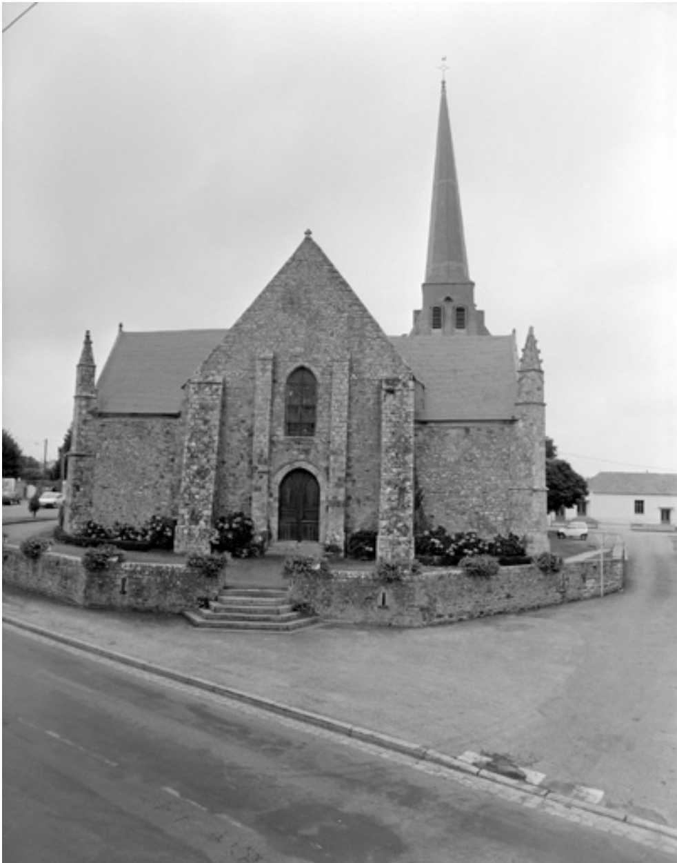
Vue générale de la façade ouest
