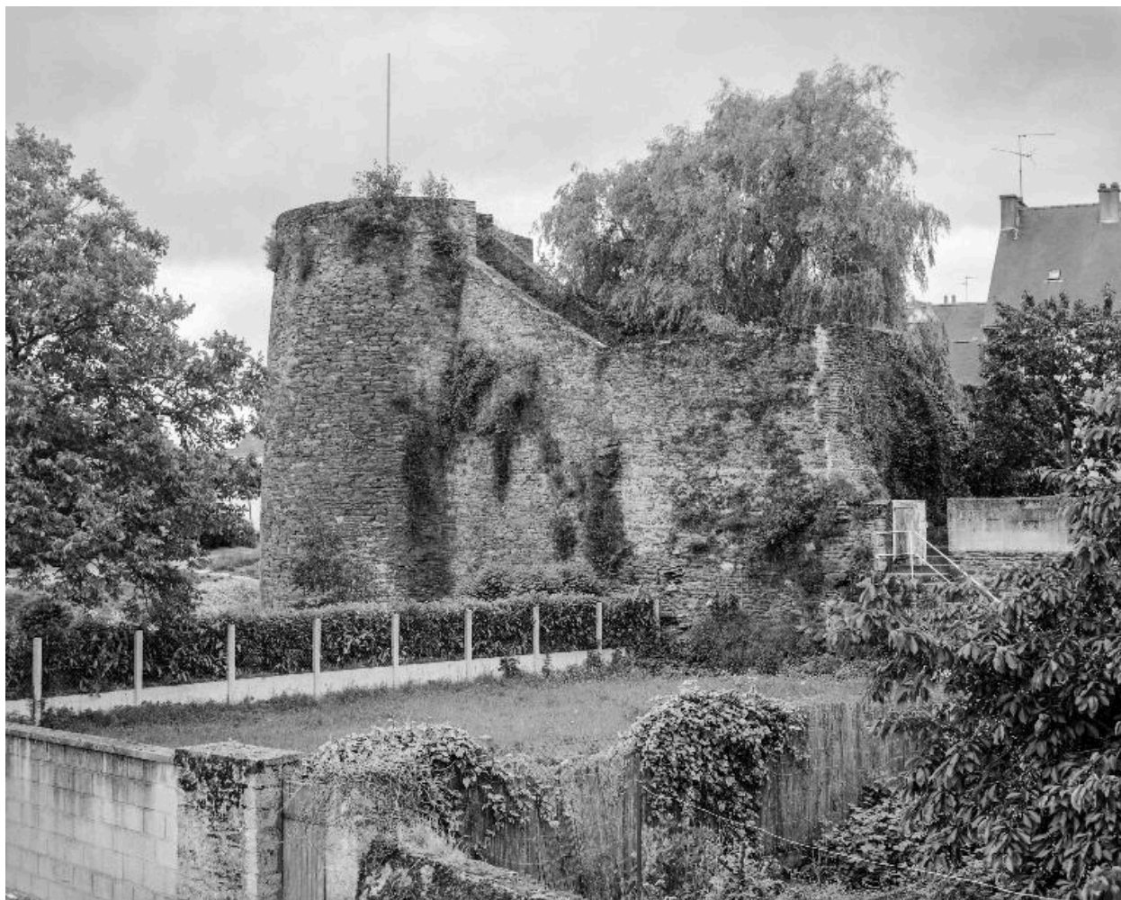
Fortification d'agglomération : rue Mystringue (état en 1985)
