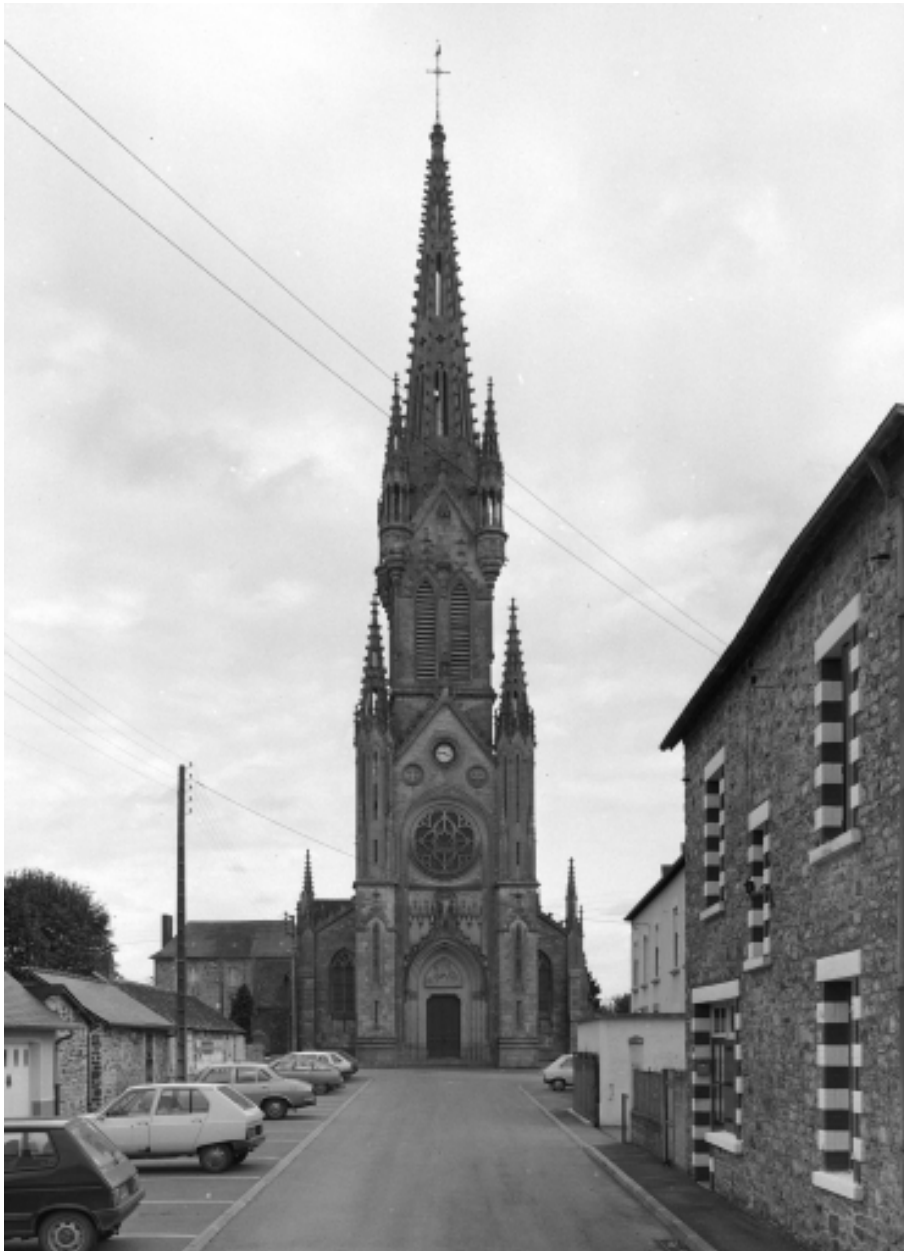
Elévation ouest, vue générale.
