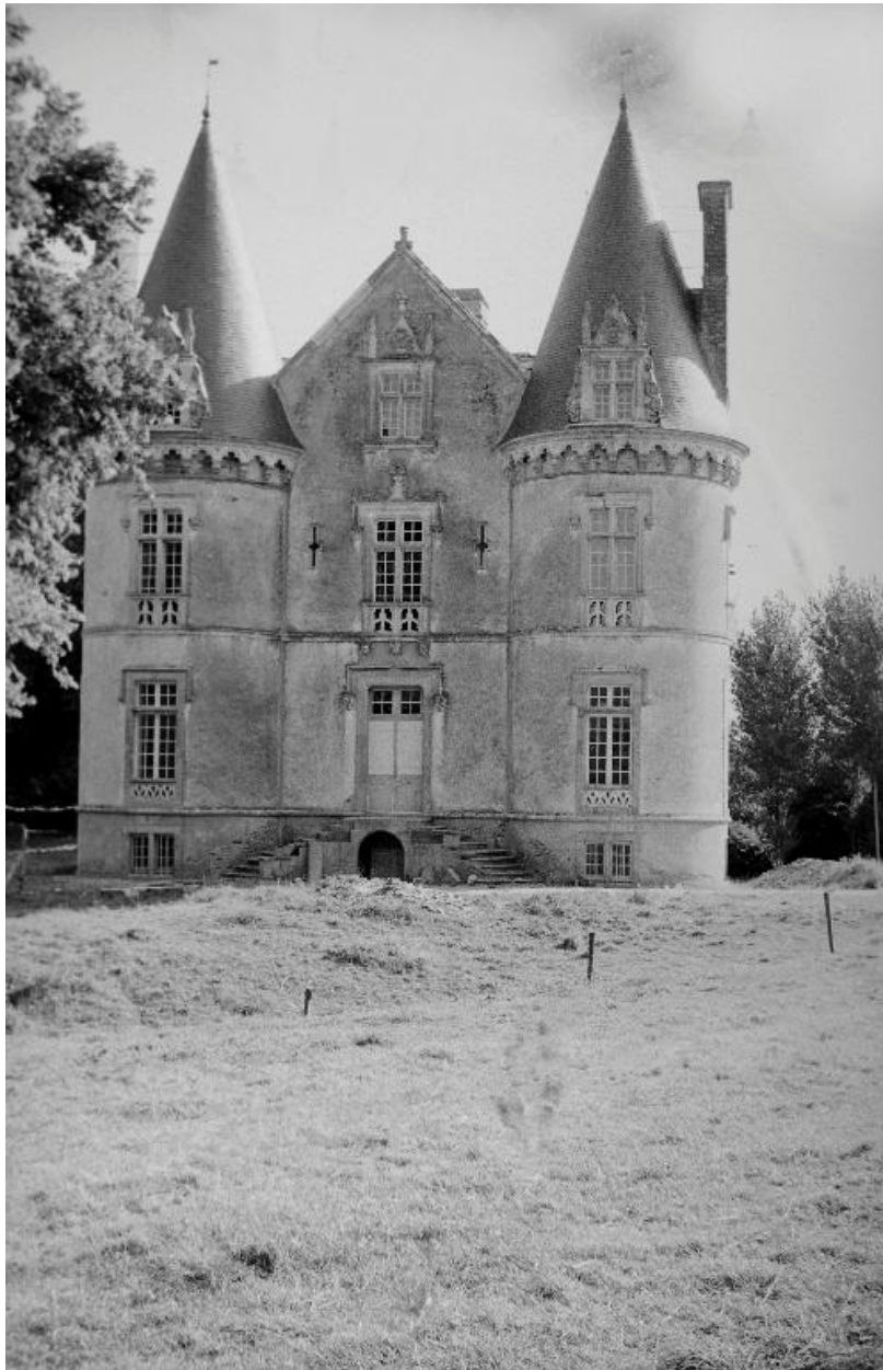
Château, logis : élévation ouest (état en 1969)
