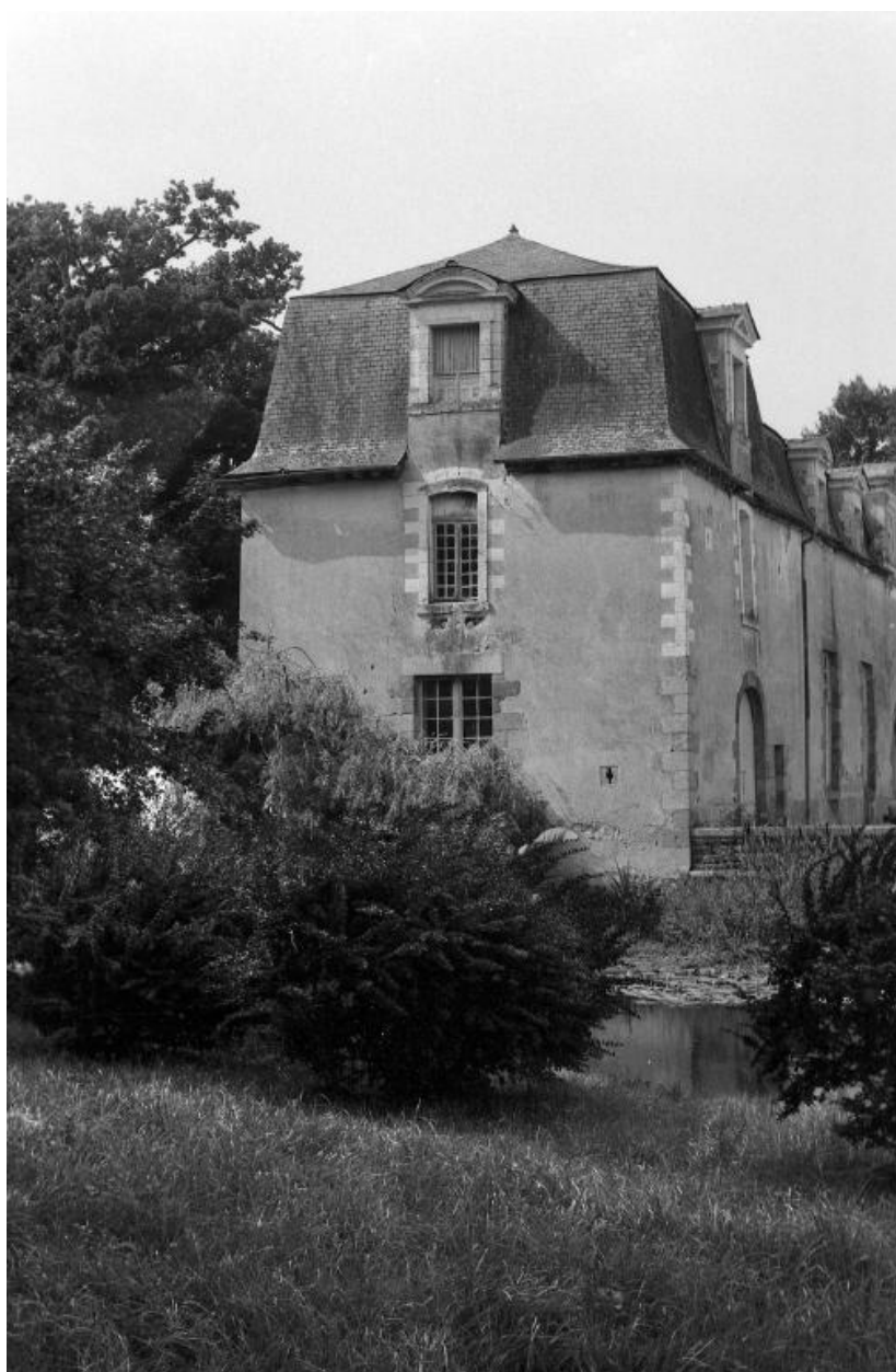
Dépendance, vue sud (état en 1973).
