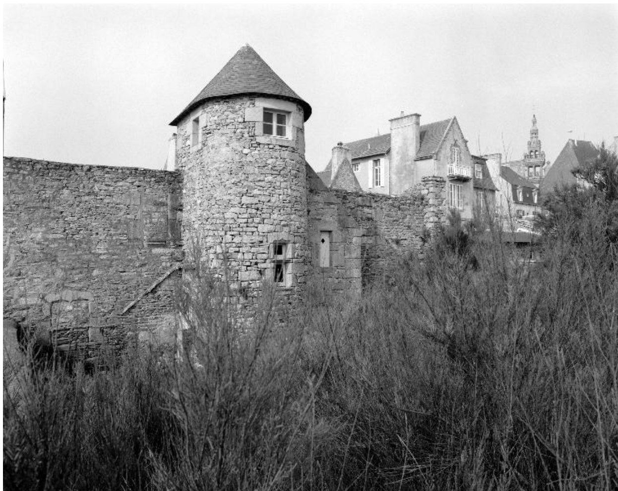
9 rue Amiral Réveillère, vestiges d'une maison, élévation nord, vue générale
