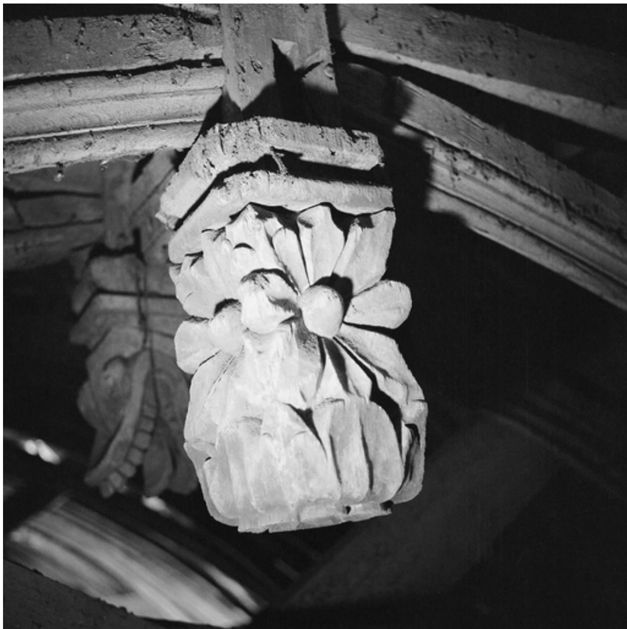
Charpente, détail de la clé 25.
