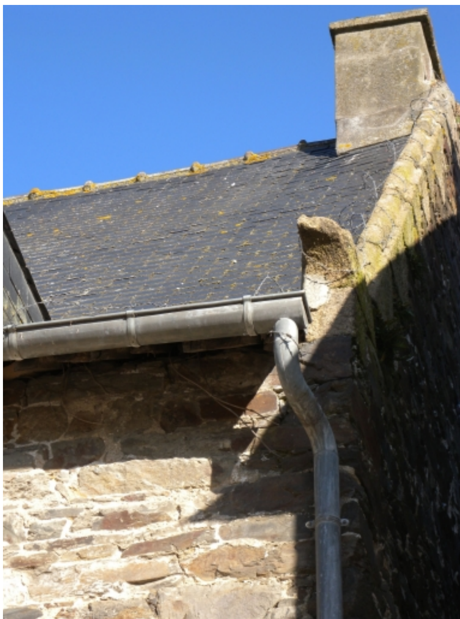
Vue de détail d'un rempant à crossette au niveau de la toiture
