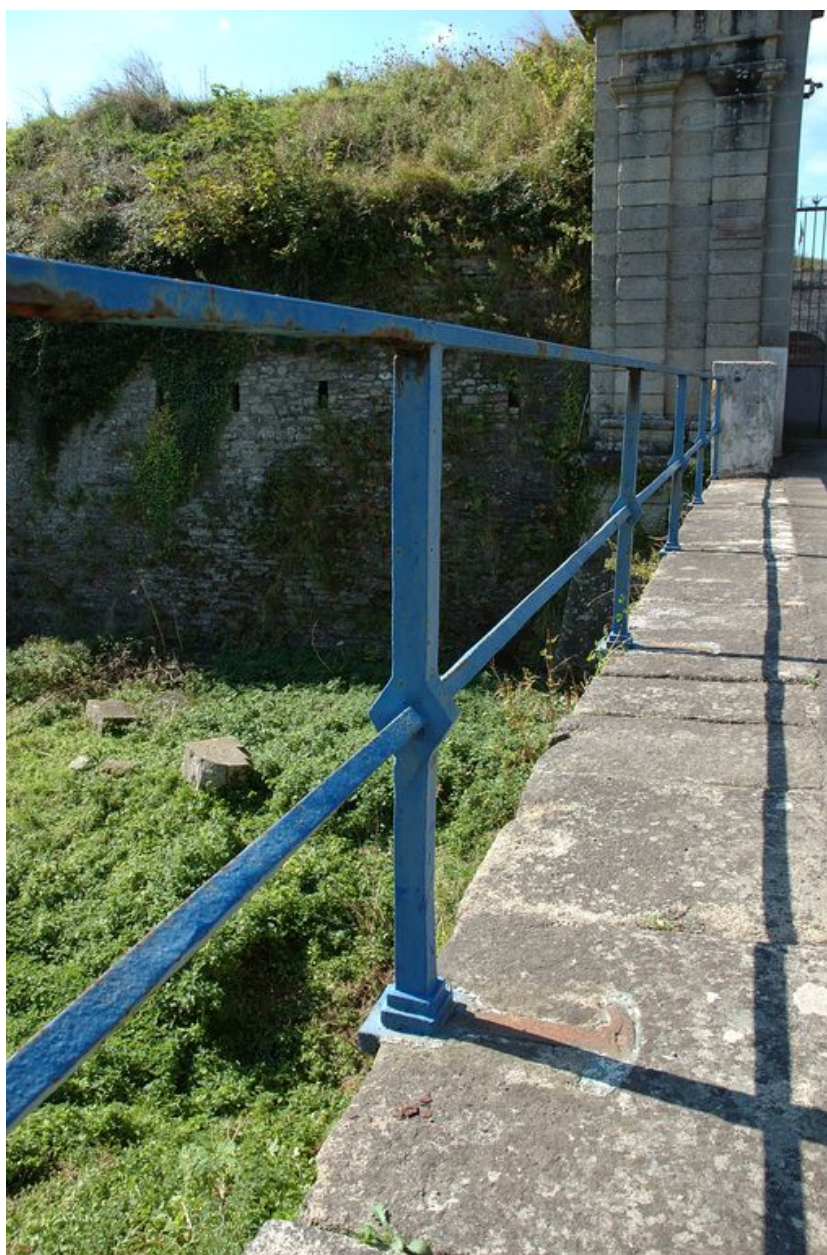
Vue de l'entrée monumentale : garde-corps en ferronnerie
