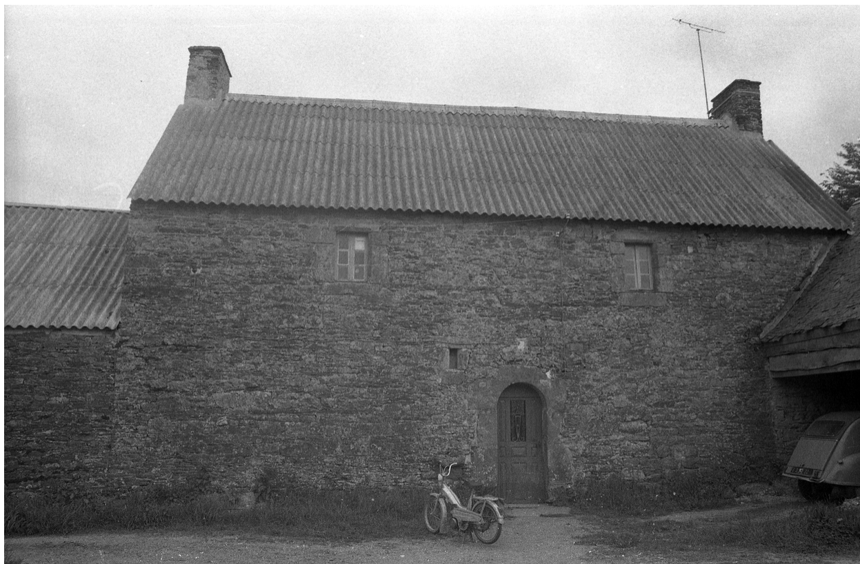
Vue générale de la façade nord
