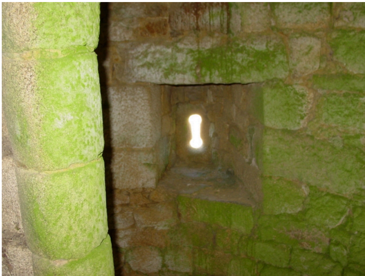
Ancien logis, tour d'escalier sud-ouest : bouche à feu, vue intérieure.
