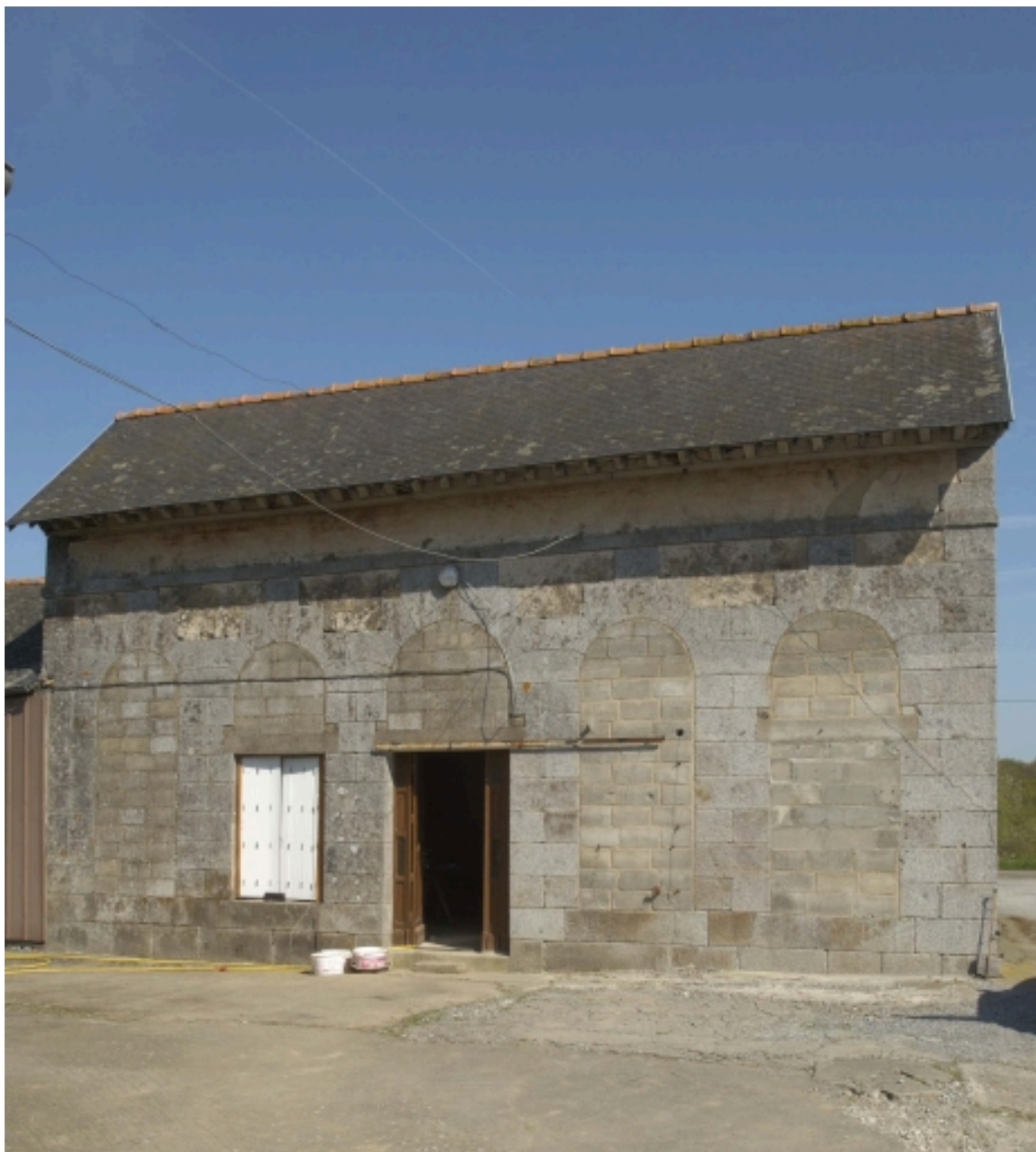
Façade sud d'une dépendance du château.
