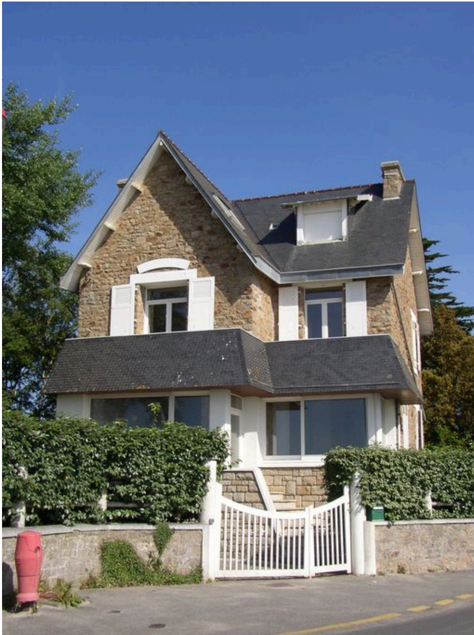
Vue générale de la maison de villégiature du 30 boulevard de Toulhars
