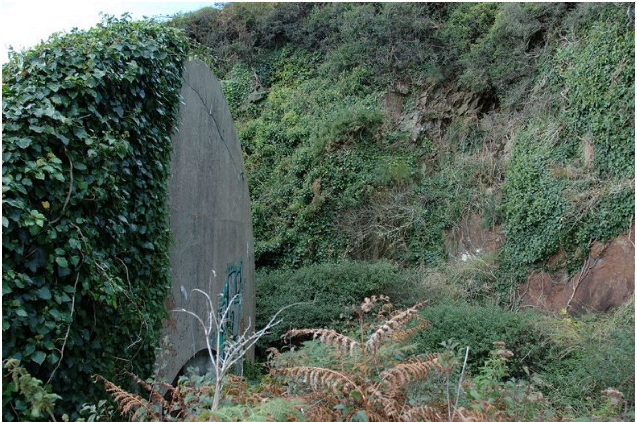
Vue des casemates de projecteur (état en 2007)
