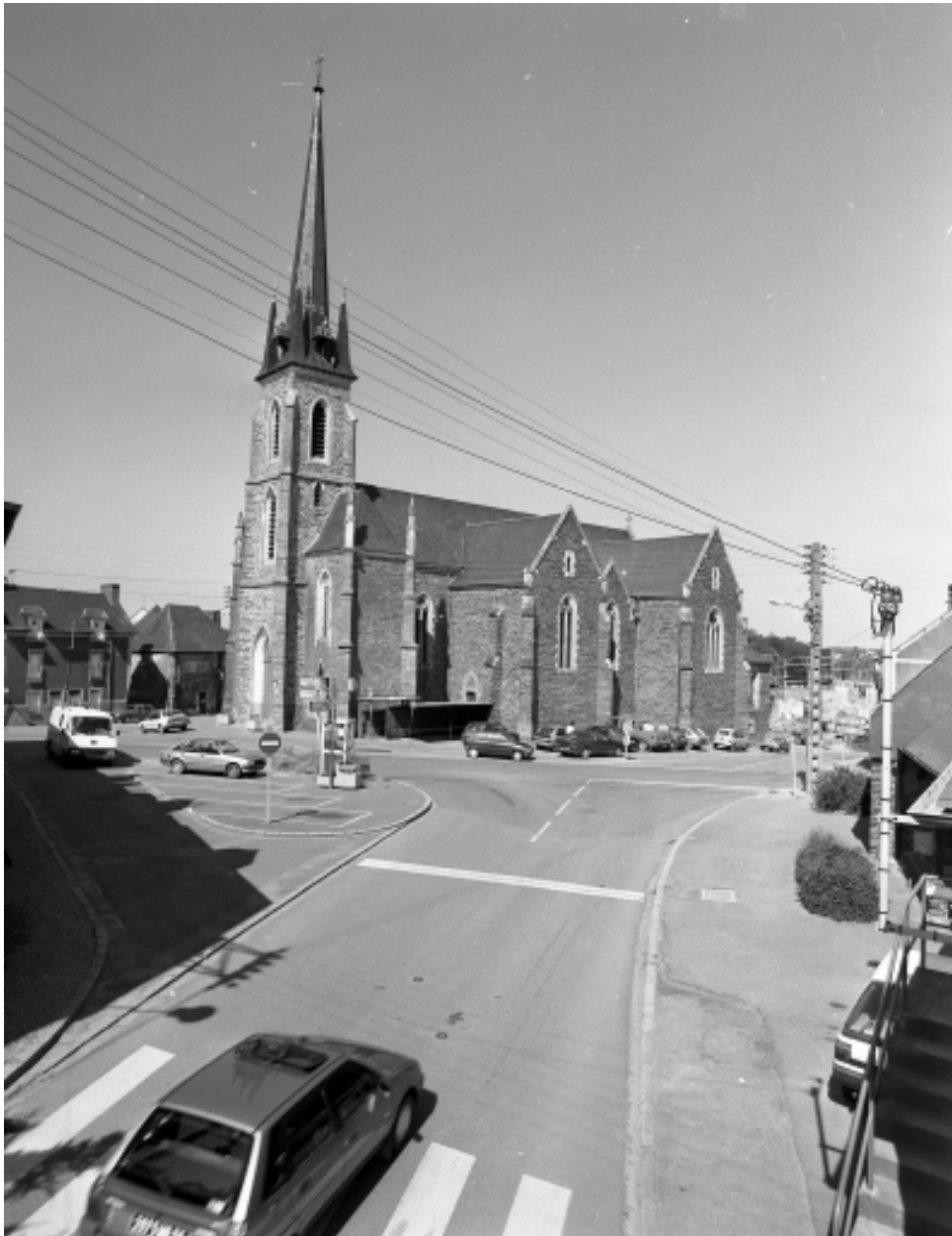
Elévation sud ouest : vue générale
