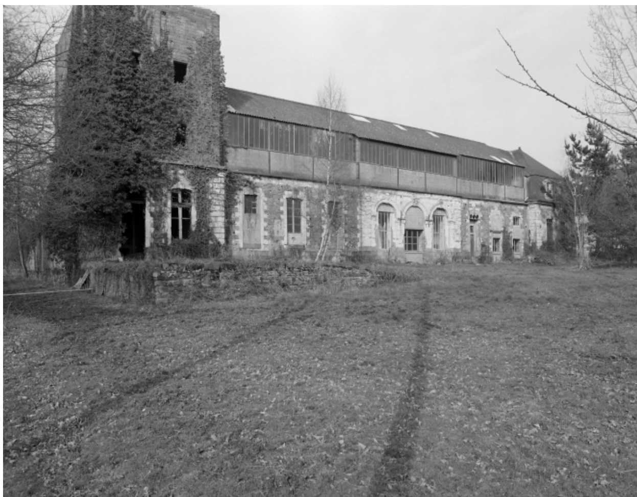
Vue générale sud ; état en 1982
