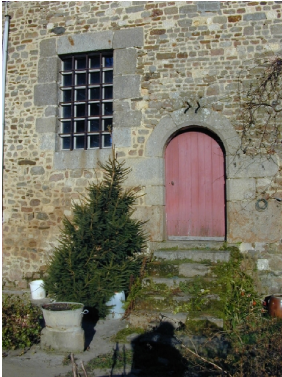
Longère sud, porte donnant sur la cour du presbytère : vue générale
