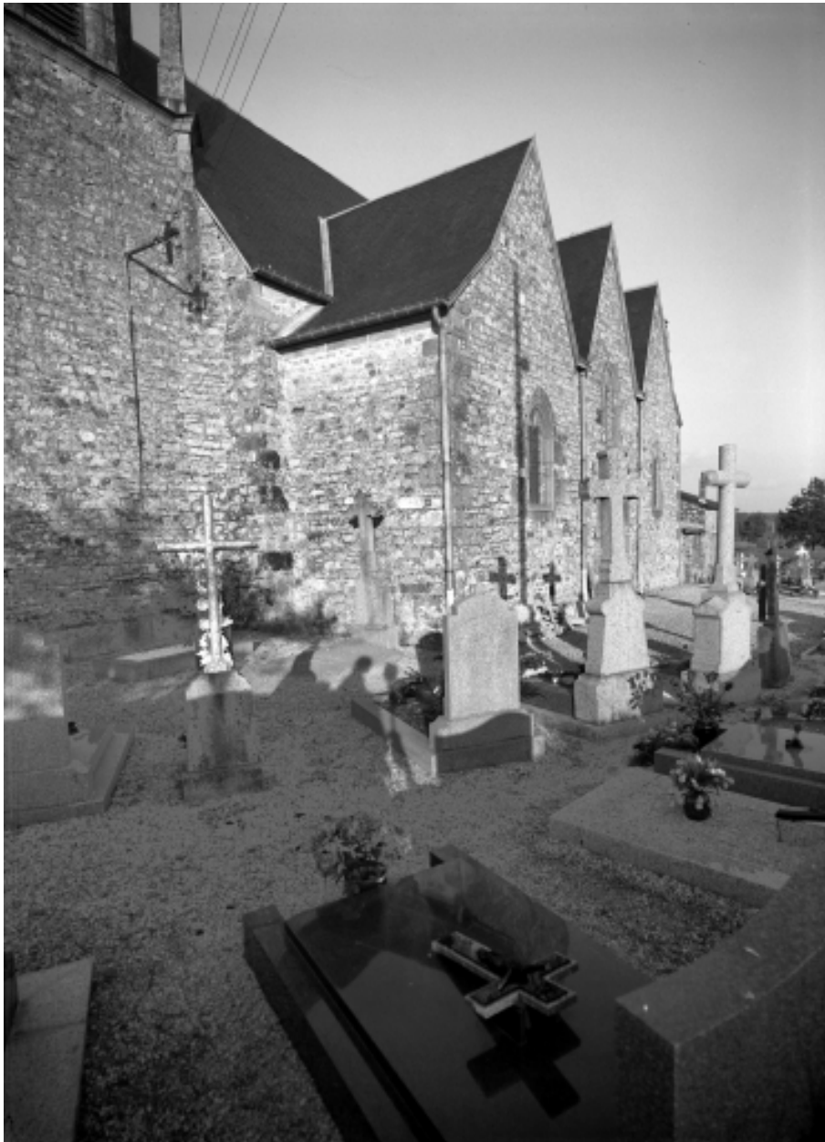
Elévation Sud, partie centrale : vue générale de 3/4
