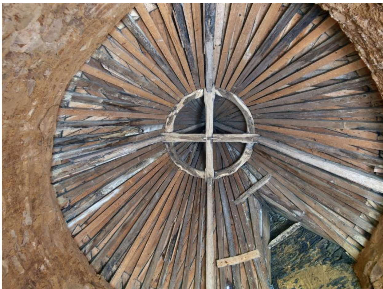
Vue de la charpente.
