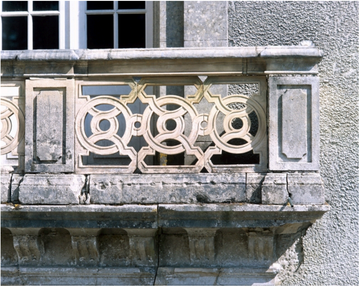
Élévation principale : détail du balcon.
