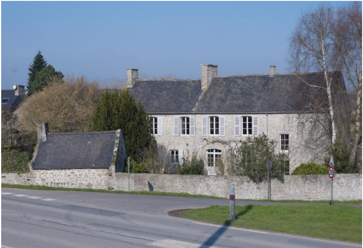
Le presbytère et le fournil depuis la route de Dinan.
