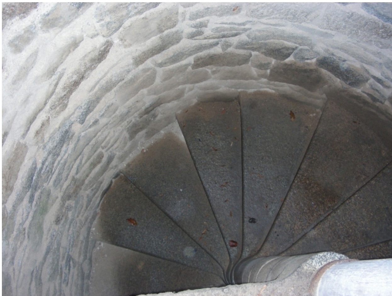
Escalier dans la tour sud
