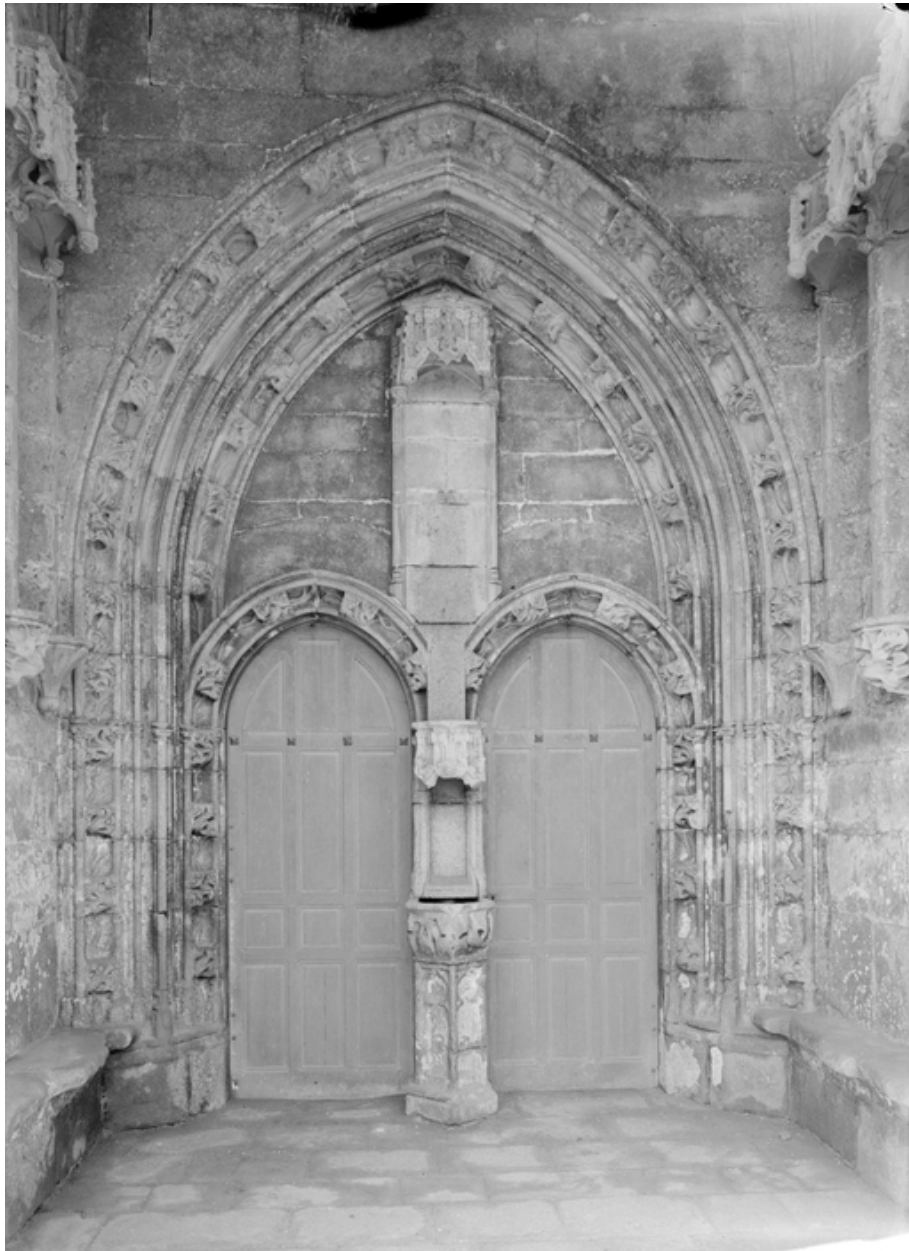
Porche sud, mur nord, portail d'accès à la chapelle.
