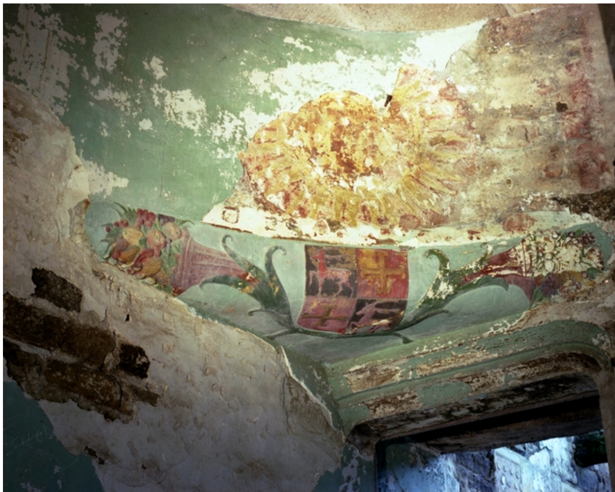
Etage, escalier, porte d'accès au corps central : décor peint et sculpté.
