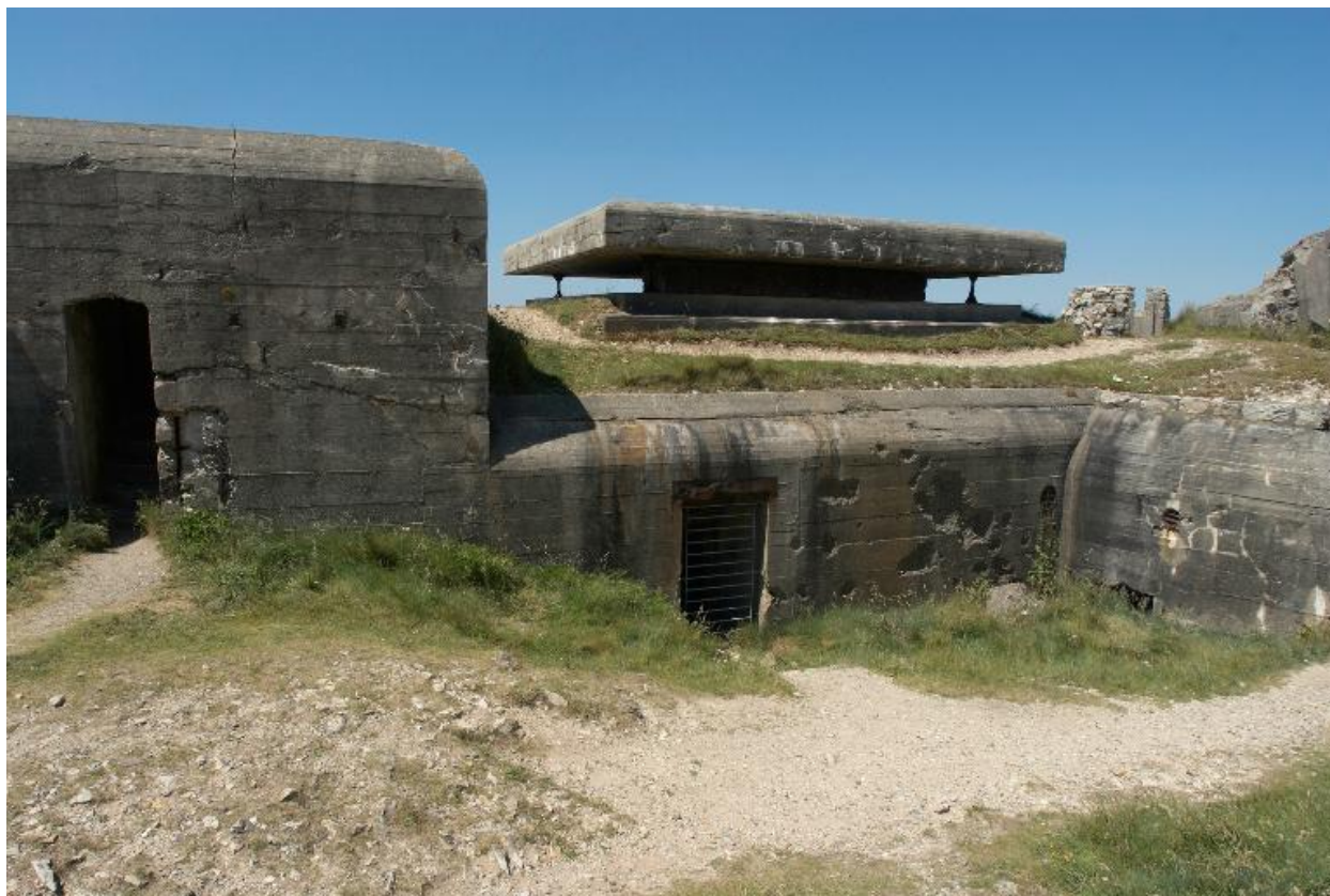
Vue du bunker - poste de direction de tir de type M162a
