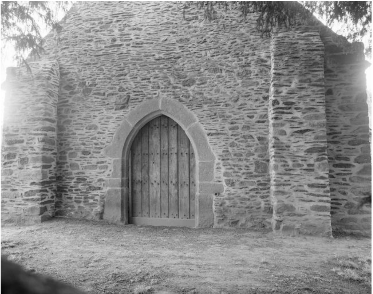
Elévation ouest : la porte
