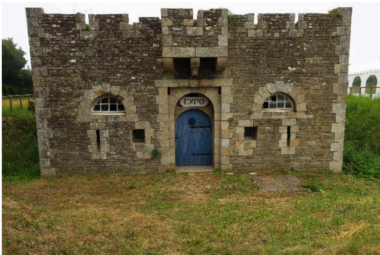
Groix, batterie du Gripp, corps de garde crénelé, façade sud.
