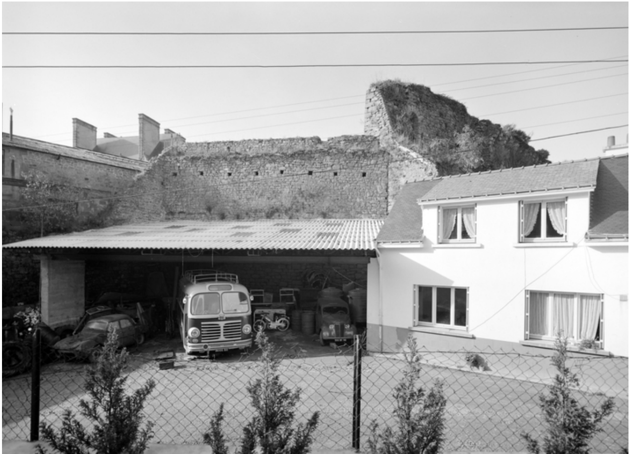
Vue nord-est du mur prise du petit jardin de la rue Joseph Peres
