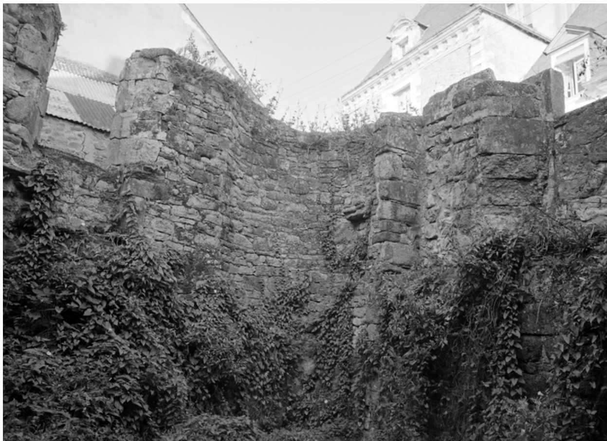
Vestiges dans la partie arrière, le long de la rue du Château.
