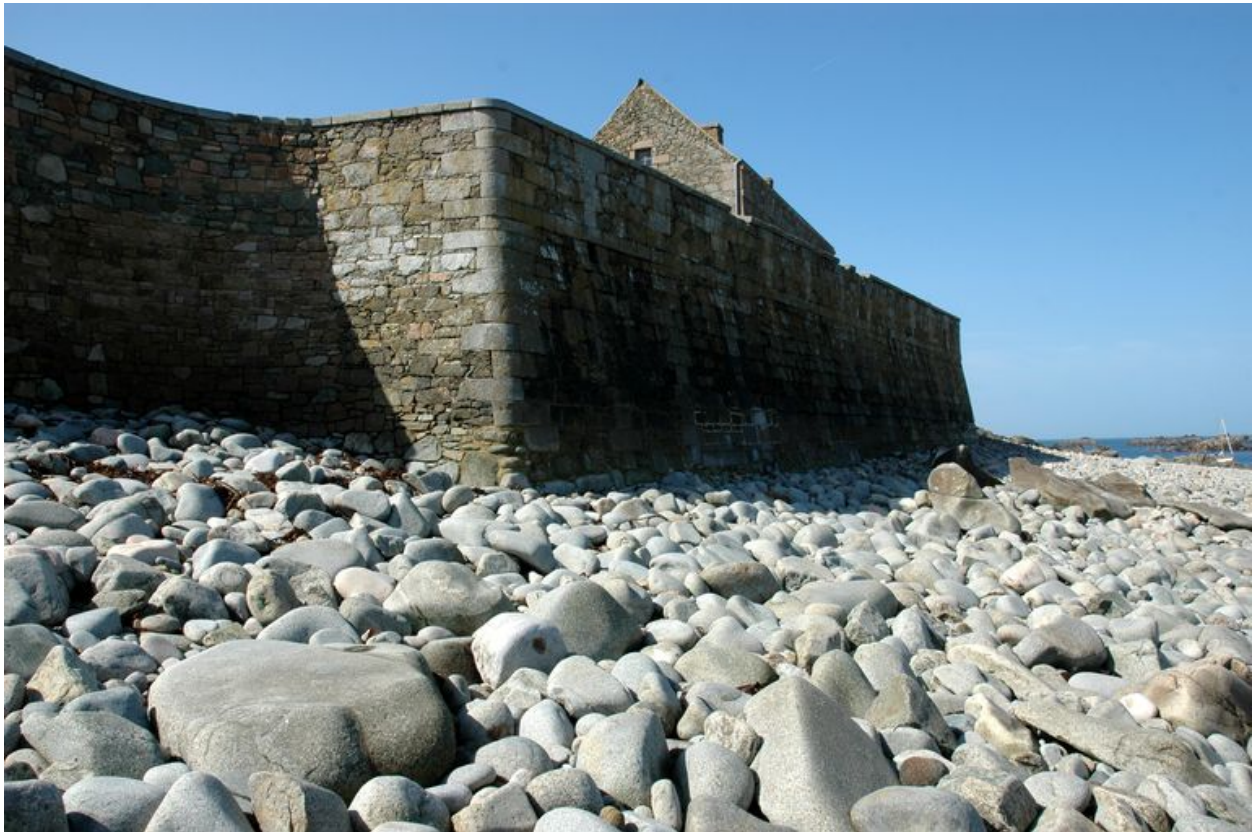
Vue générale depuis la grève (état en 2006)
