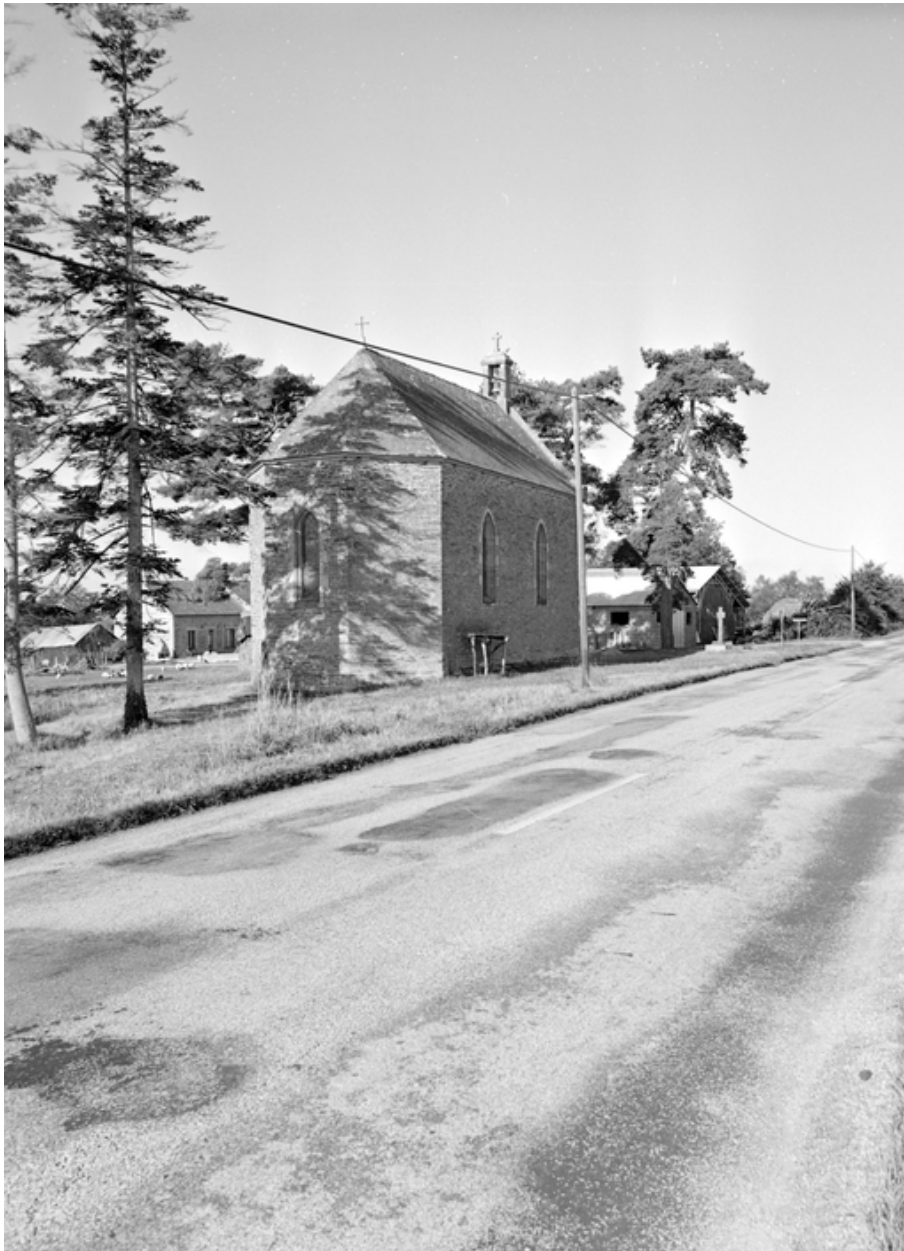
Vue générale nord-est.
