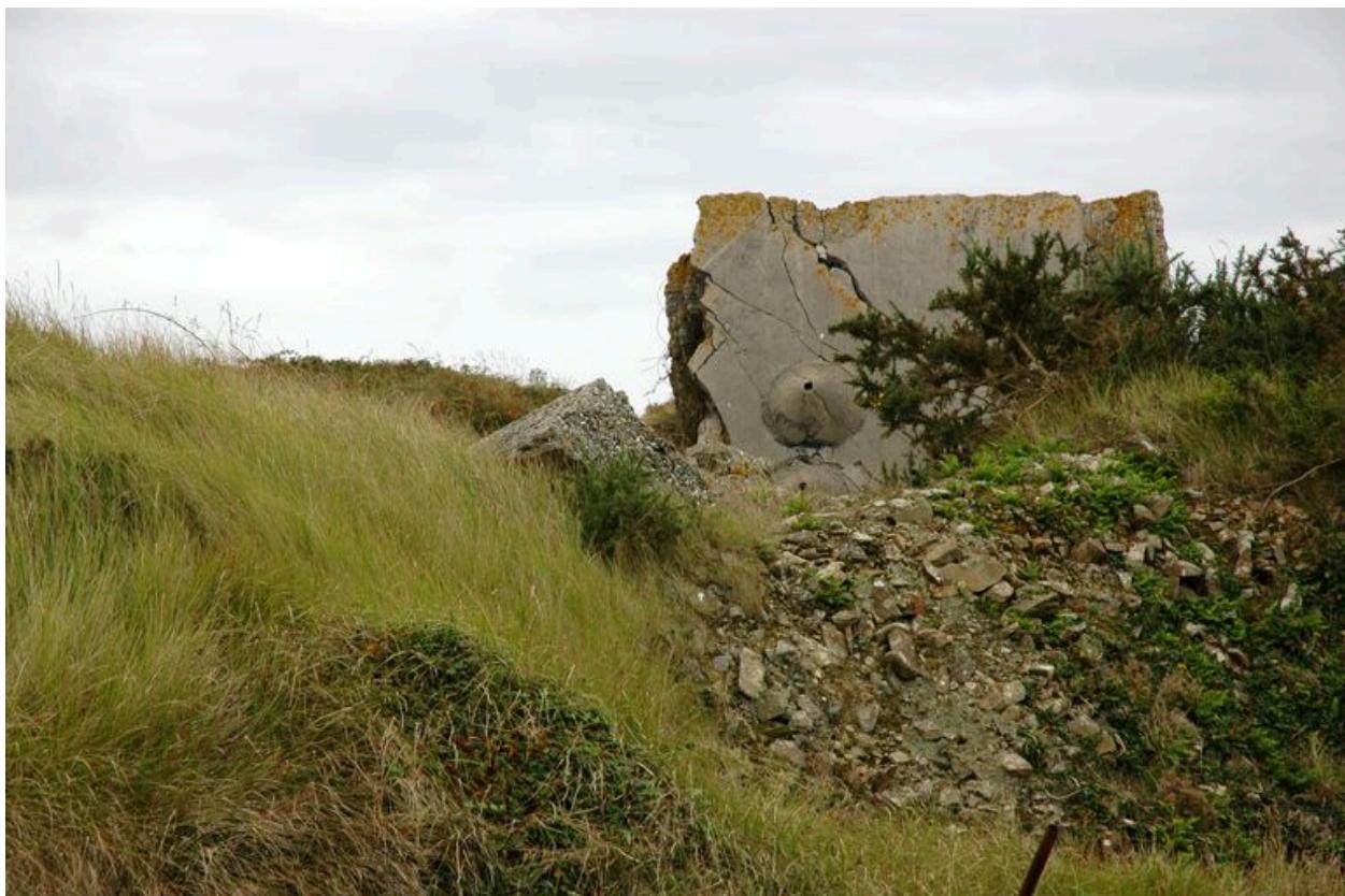
Vue générale de l'angle nord (saillant II) depuis le glacis. Ce saillant comprenant une tourelle de canon de 75 mm et un observatoire blindé a été bouleversée par une explosion dont on observe les effets (amas de béton armé et lézarde de l'escarpe)
