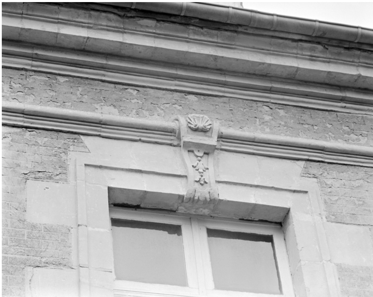
Elévation est, détail d'une baie du premier étage.
