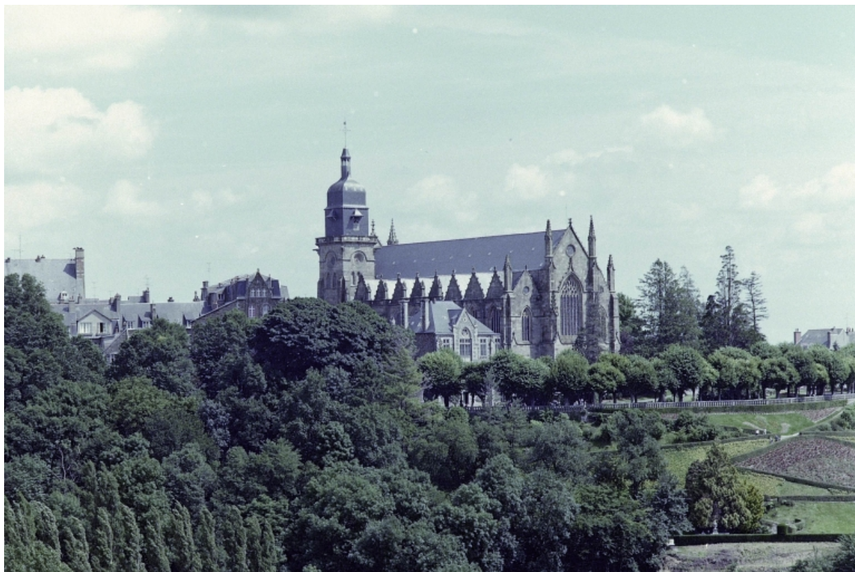
Vue de situation nord-ouest.
