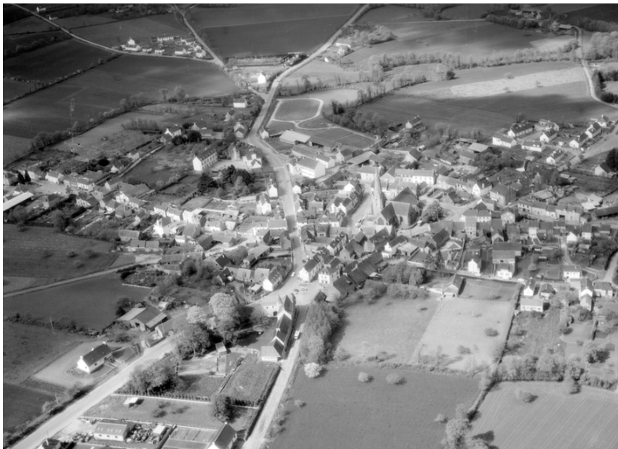
Vue aérienne nord-est.
