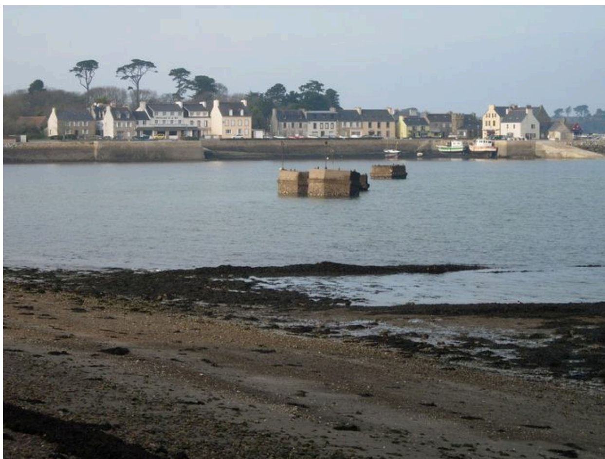
Vue du Front portuaire du Fret
