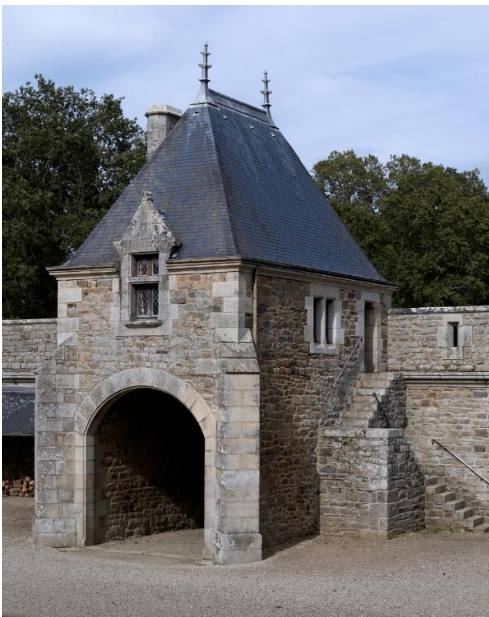
Vue du pavillon abritant la porte charretière (logis-porche)
