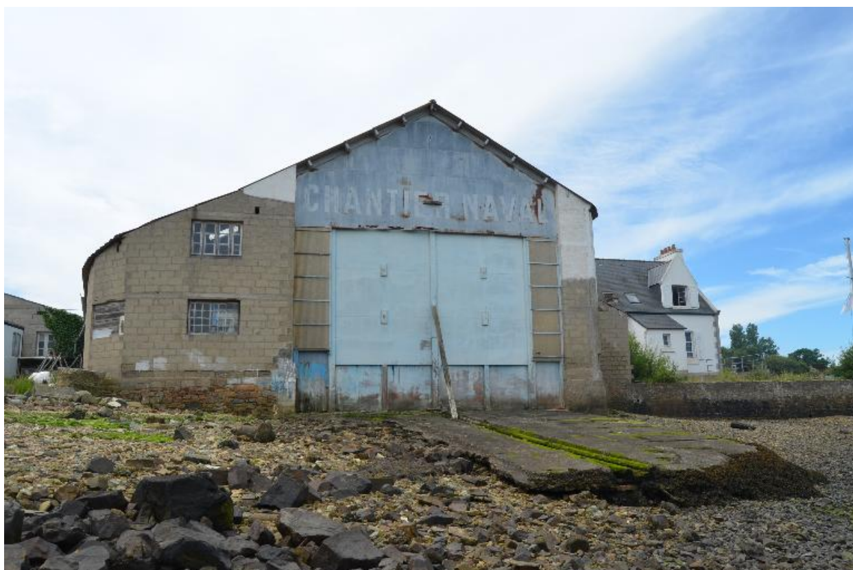
Chantier Rolland Marine, Diben à Plougasnou
